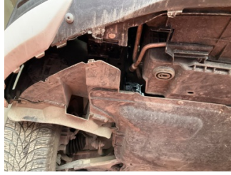
Motor, Alt muhafaza > Hasarlı
